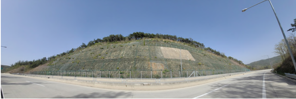
영천절토 34 (관리이정 1.890~2.150km / 5공구 군위R-A(중앙)STA.1+890~2+150)
