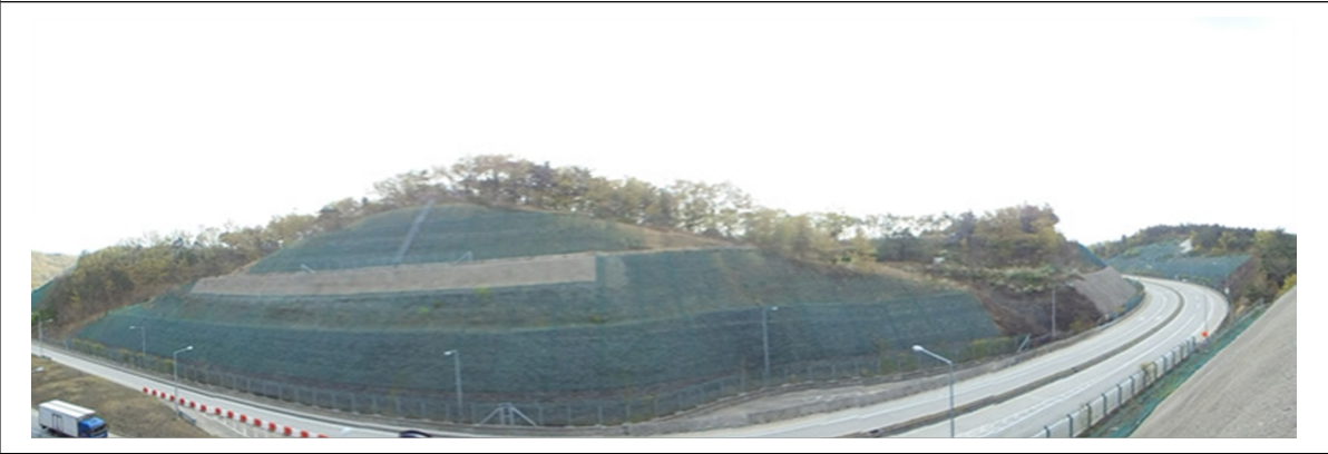
영천절토 58 (관리이정 0.920~1.340km / 8공구 화산JCT R-A 우측 STA.0+920~1+340)
